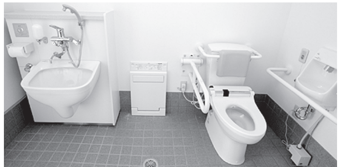
▲トイレの内部
