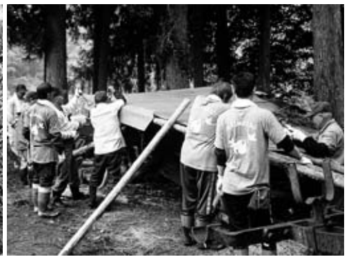
▲倉庫の撤去作業(安岐の郷の皆さん)
