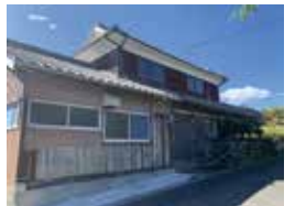
▲空き家を改修して貸し出し
