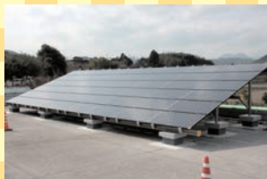
屋上に設置されたパネル (1枚のサイズは横1580mm×縦812mm)
