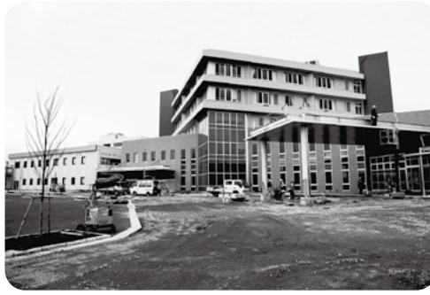
3月末のグラウンドオープンに向けて工事の進む国東市民病院(1月23日撮影)
