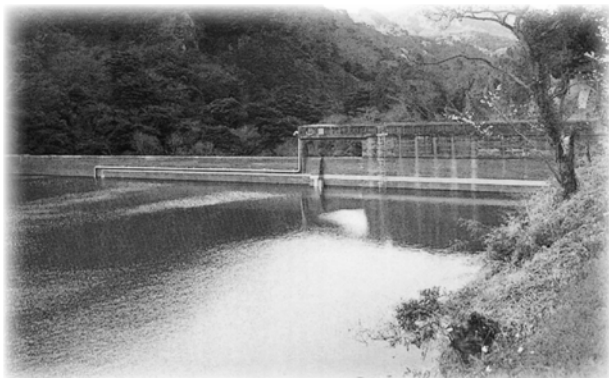
改修される一ノ瀬ため池
