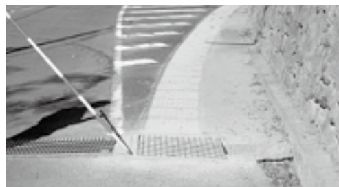
設置された蓋
