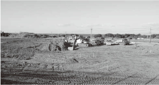
▲造成工事が進む消防本署(国東町北江)
