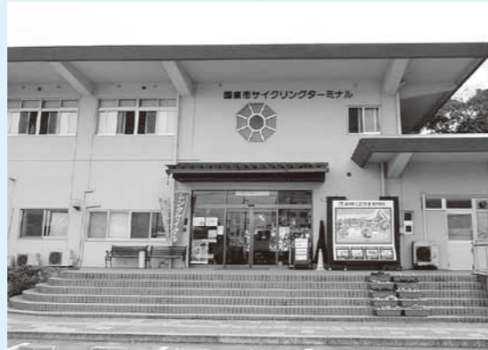
▲「道の駅くにさき」にある国東市サイクリングターミナル
