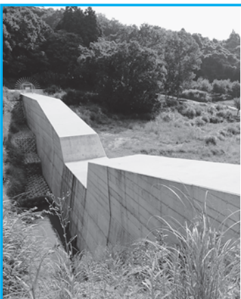
▲写真左側が上流（国東町見地川砂防ダム）
