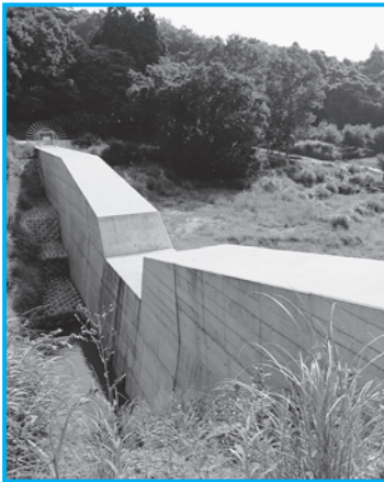
▲写真左側が上流（国東町見地川砂防ダム）
