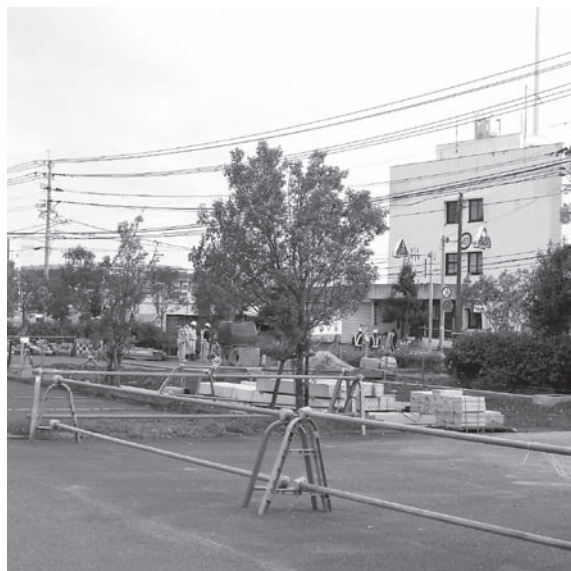
工事が進む新庁舎建設現場
