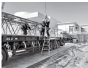
▲クローラークレーンの組立状況
