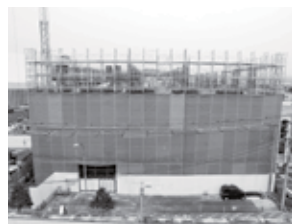
▲4階床までの躯体施工状況
