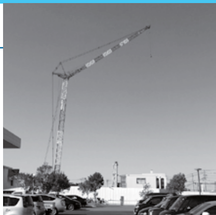
▲組立当時のクローラークレーン全景
