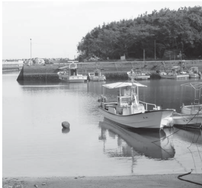
浚渫が始まる黒津漁港
