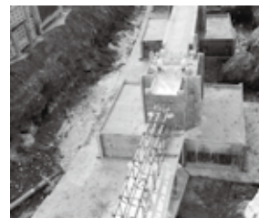
◀くにさき回廊の 基礎工事
