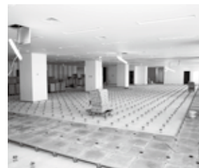
◀2階フロアー工事の 様子
