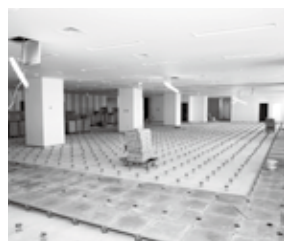
◀2階フロアー工事の様子
