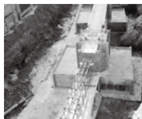
◀くにさき回廊の基礎工事
