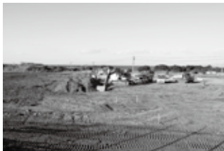
▲平成26年3月10日 用地造成工事の様子
