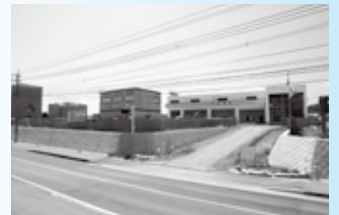
▲平成27年3月26日 新庁舎建設工事の様子
