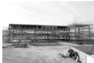
▲平成27年1月5日 新庁舎建設工事の様子
