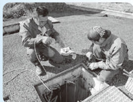
▲浄化槽点検作業
