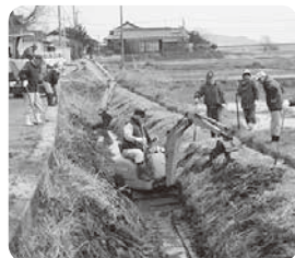
▲排水路の重機による泥上げ
