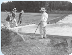
▲農道整備作業
