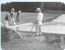
▲農道整備作業
