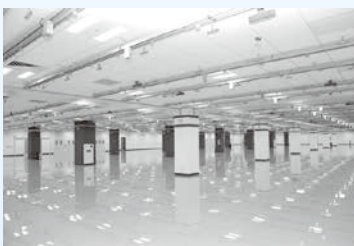
◀総合技術棟の 一階部分の様子
