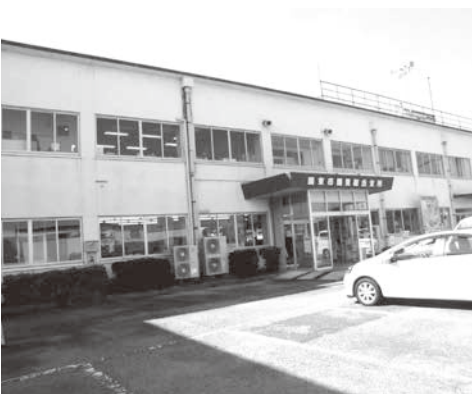
早期改修が望まれる国見総合支所
