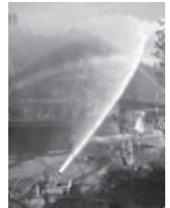
▲自動放水銃による消火訓練の様子
