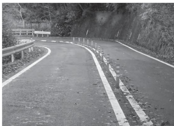
中央分離帯に設置されたコーン・ブロック
