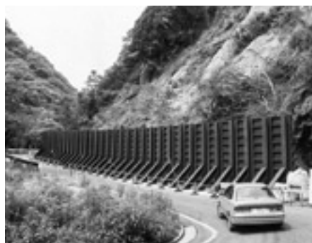
▲昨年の大雨で、地すべりを起こした県道山香国見線(国見町地蔵峠付近)
