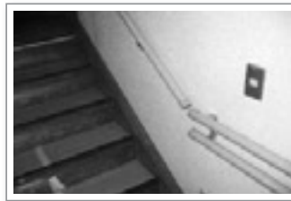
対応例1 「手すりの設置」
