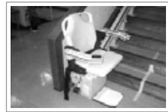
対応例2 「階段昇降機の設置」
