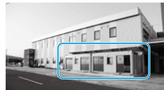
発熱外来用の診療施設を病院外部に設置。
