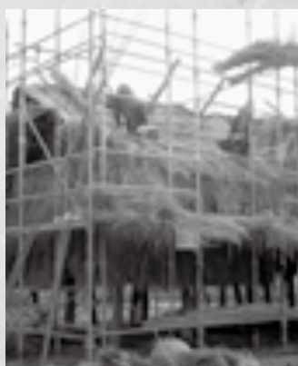
再整備の一環で高床建物を修理。
