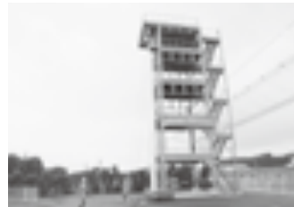
市消防本部の訓練塔
