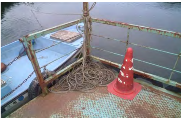
救出用安全ロープの常時設置
