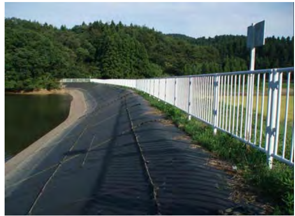
堤体法面に安全ロープの設置
