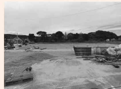
分譲地造成が進む 旧安岐中央公民館大ホール跡地
