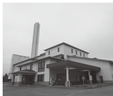
直接搬入の中継施設となる 国東市クリーンセンター
