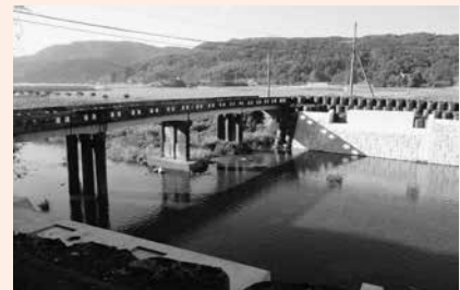
架け替え工事が進む武蔵の成吉橋
