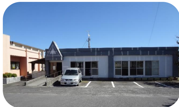
《 隣保館 別館 外観 》
