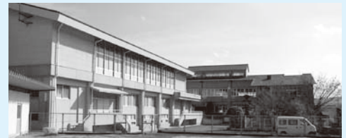
▲廃校となった旧朝来小の校舎に福祉施設を誘致
