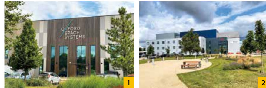
1 人工衛星用レーダー・アンテナ開発企業。2 National Satellite Test Facility。最大7トン級の人工衛星までの首嘗試験や電磁試験などが可能な衛星試験施設。
