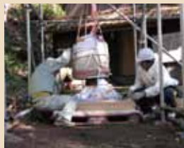
②塔身部取り外し
