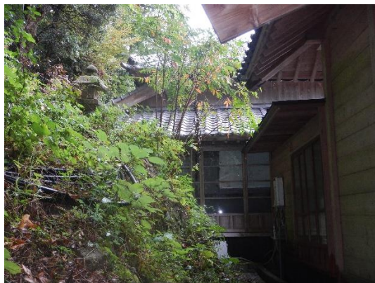
建物背後の斜面と植生
