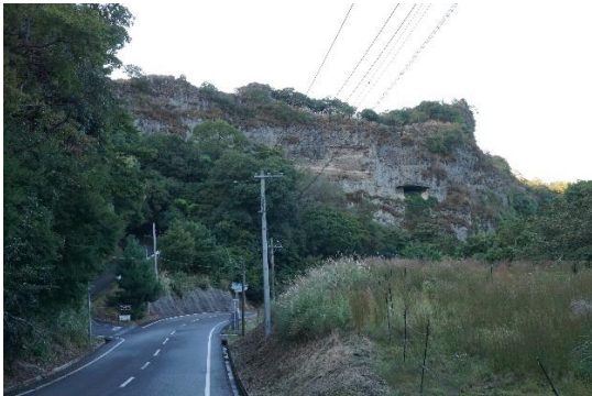
堀岩（市道南から）
