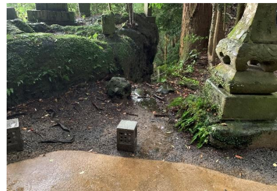
降雨によって生じる階段脇の水みち
