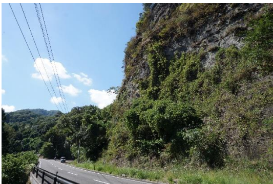
塀岩に繁茂する植物
