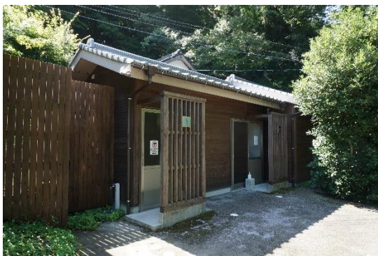
境内トイレ（東参道駐車場）
