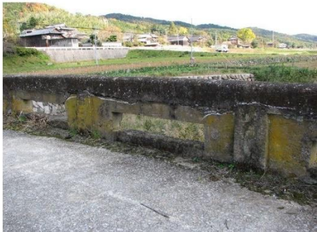
防護柵改良前
