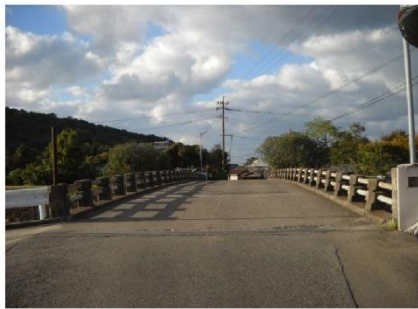
舗装、地覆、防護柵改良前
