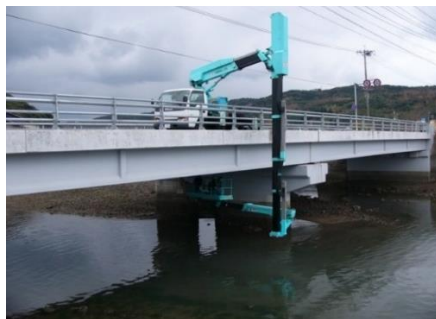
写真 1 橋梁定期点検状況（イメージ）
