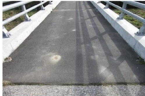
防護柵改良後
