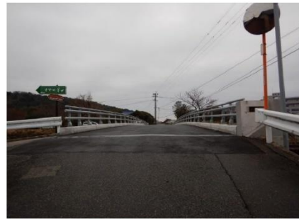
舗装、地覆、防護柵改良後
