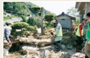
▲流木の撤去作業
