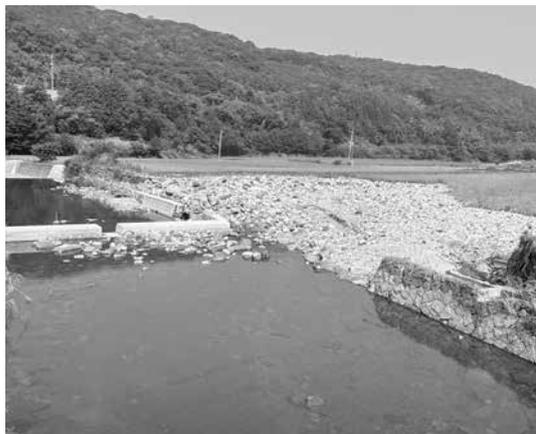
井堰により河道断面積が狭いため決壊した災害現場
