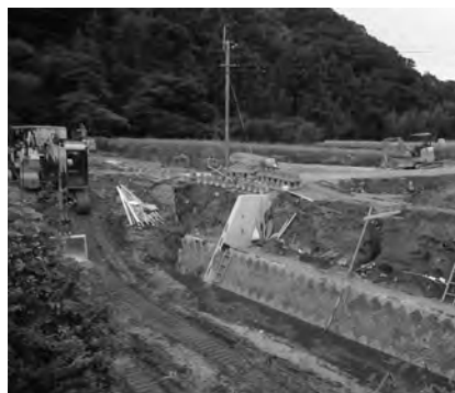
災害復旧工事（安岐町）
