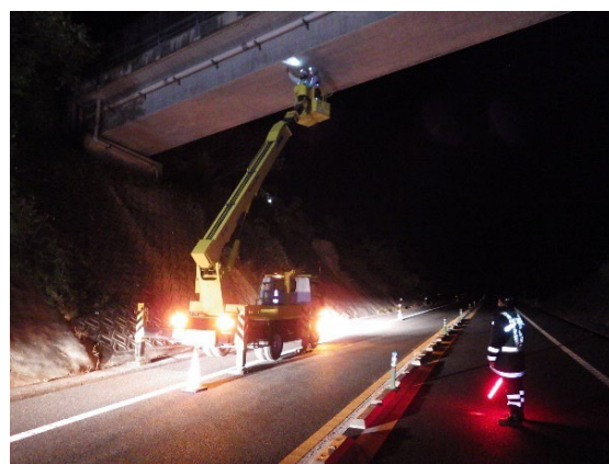
【高所作業車による点検状況】
