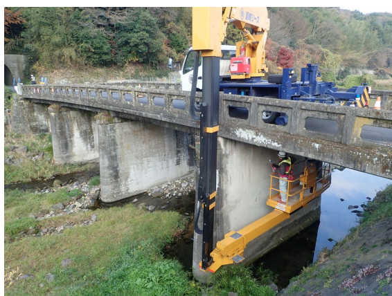
【橋梁点検車による点検状況】
