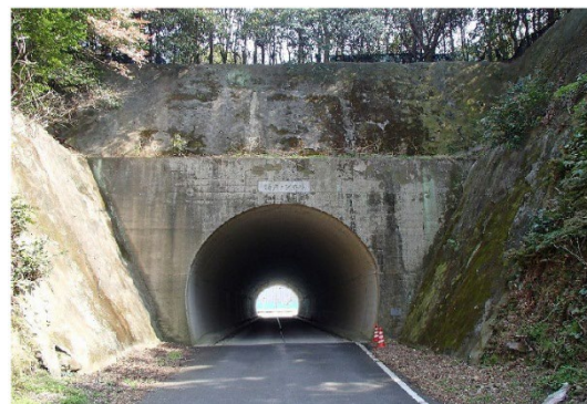
写真-2.4 楠戸トンネル
