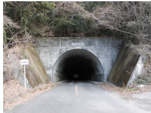
写真-2.2 志和利トンネル
