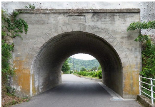
写真-2.3 箕ヶ岩トンネル
