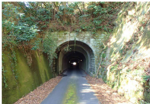
写真-2.1 朝来隧道
