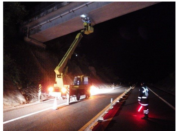
【高所作業車による点検状況】
