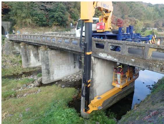
【橋梁点検車による点検状況】
