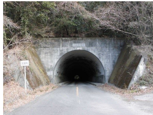
写真-2.2 志和利トンネル
