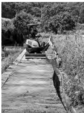
用水路の土砂撤去作業
