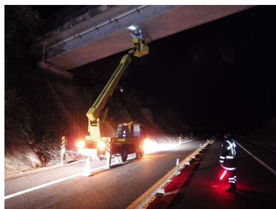
【高所作業車による点検状況】
