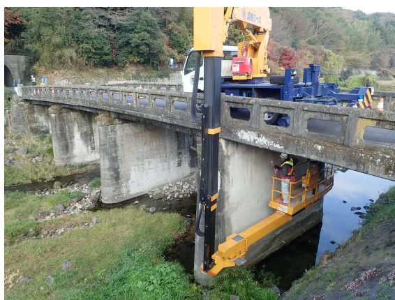
【橋梁点検車による点検状況】
