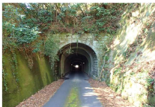
写真-2.1 朝来隧道
