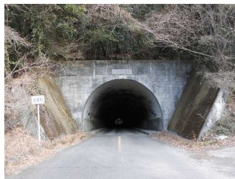
写真-2.2 志和利トンネル
