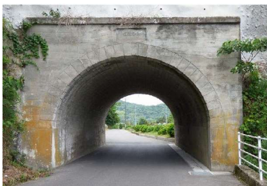
写真-2.3 箕ヶ岩トンネル
