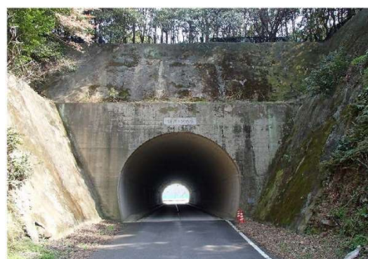
写真-2.4 楠戸トンネル
