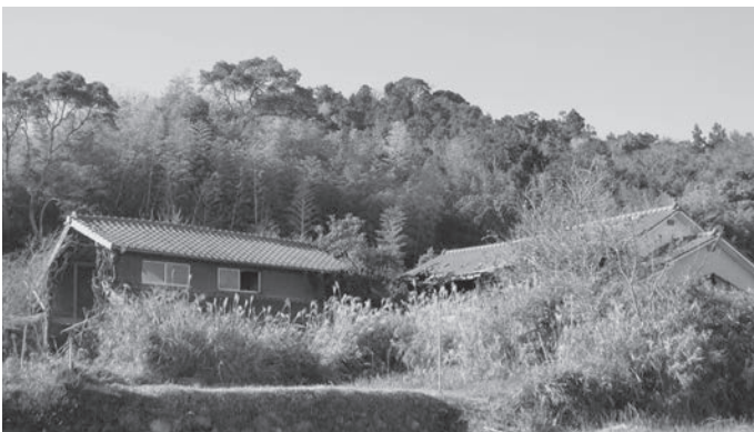
崩落の危機にある空き家
