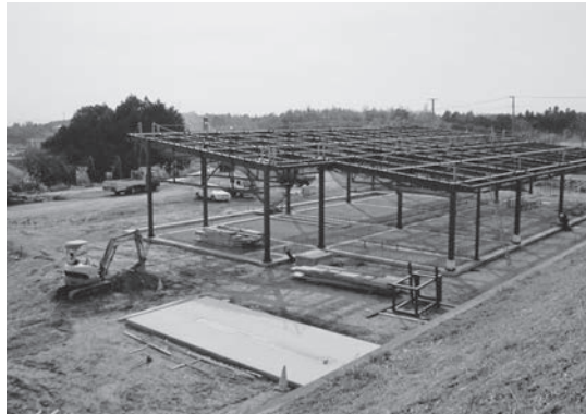
建設中の国東市消防署南分署
