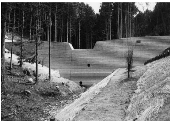
国見町西方寺地区の治山ダム
