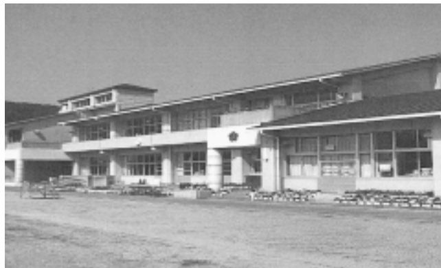
国東市立西武蔵小学校
